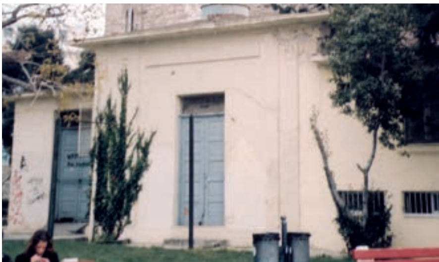
Εικ. 71: Το αντλιοστάσιο του Λευκού Πύργου όπως είναι σήμερα (2004).
