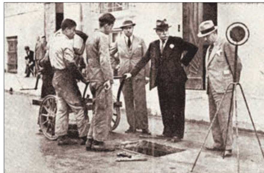
Εικ. 48: Φωτογραφία από έντυπο της εποχής με τον δήμαρχο Θεσσαλονίκης Νικόλαο Μάνο, συνοδευόμενο από τον υπομηχανικό Γιαννουκάκη, κατά την επίσκεψή του σε φρεάτιο του αποχετευτικού δικτύου το 1935.
