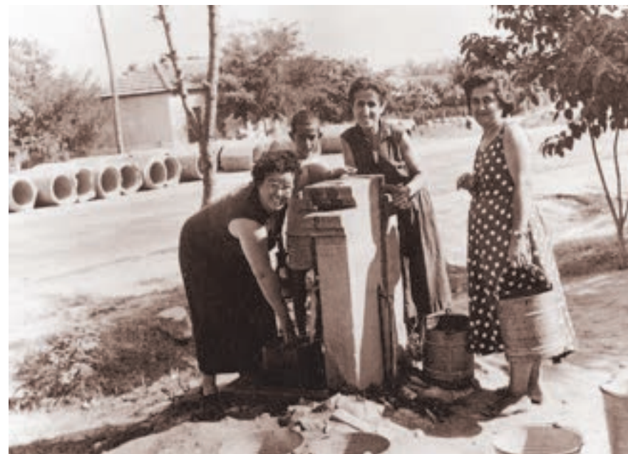
Εικ. 63: Κοινόχρηστη βρύση στην Καλαμαριά τη δεκαετία του 1950. Πίσω διακρίνονται τσιμεντένιοι αγωγοί αποχέτευσης, έτοιμοι να τοποθετηθούν στο υπόστρωμα του δρόμου.
