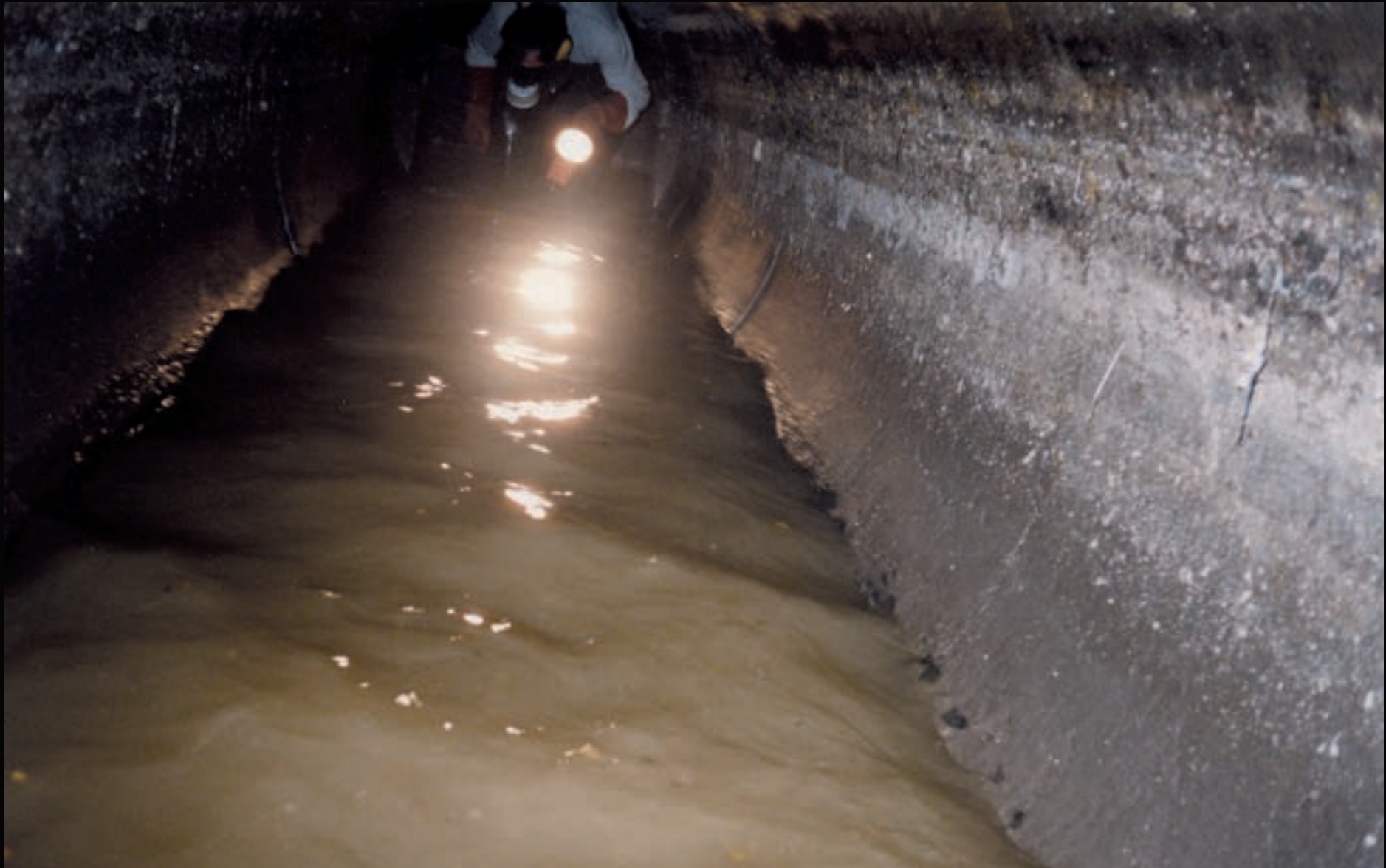
Εικ. 82: Εσωτερικό του κ.α.α. κάτω από την οδό Αλ. Σβώλου κατά τον καθαρισμό του (φωτογραφία: Χρ. Τραγανός).
