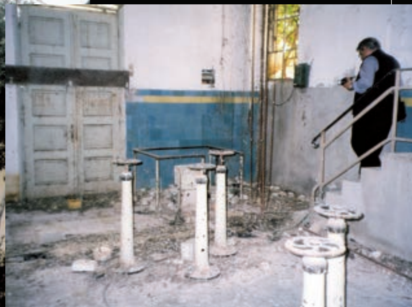
Εικ. 25: Το εσωτερικό του αντλιοστασίου του Λευκού Πύργου όπως είναι σήμερα (2004).
