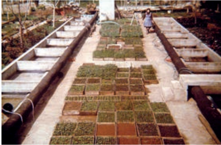
Εικ. 66: Η εξωτερική άποψη της Εγκατάστασης Επεξεργασίας Λυμάτων Νέας Κρήνης (φωτογραφία: Α. Δεληγιάννης).
