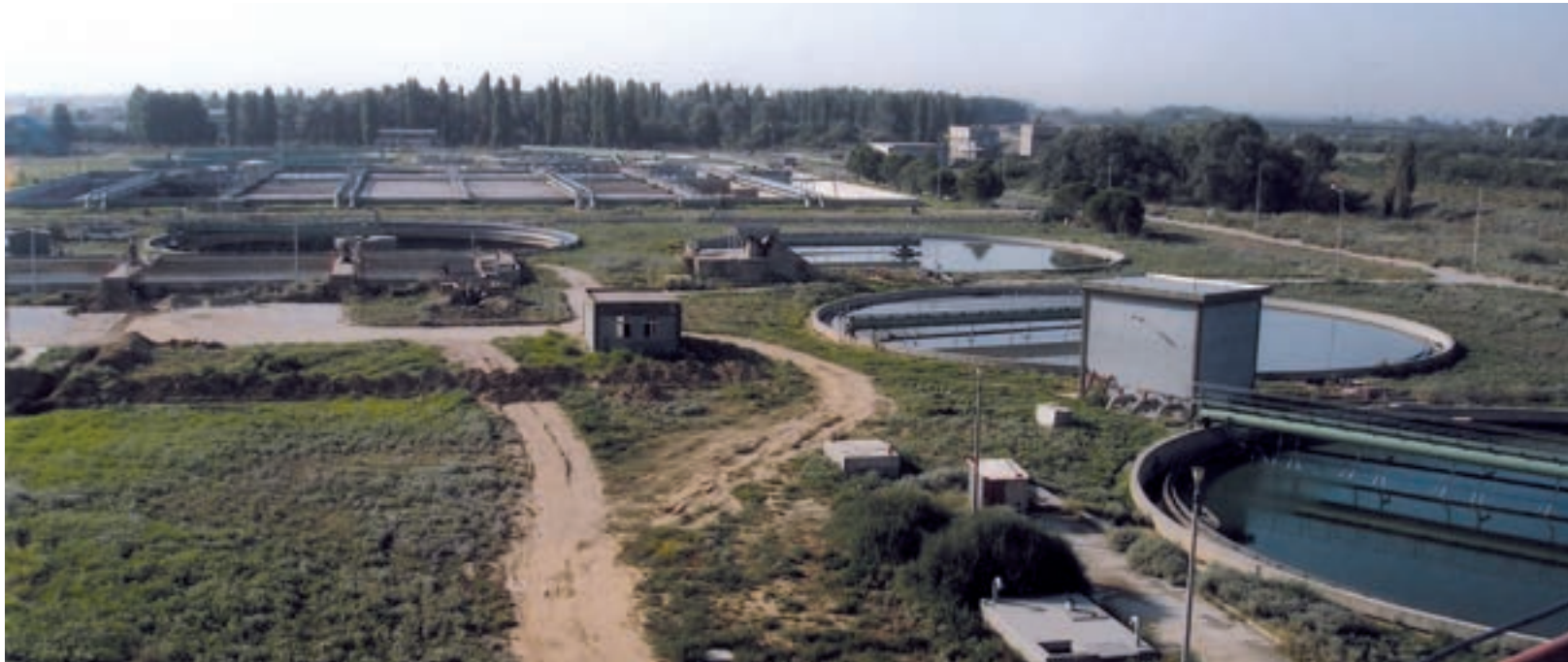
Εικ. 121: Πανοραμική άποψη των Εγκαταστάσεων Επεξεργασίας Λυμάτων Θεσσαλονίκης.
