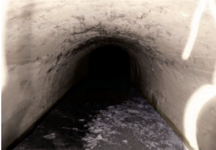
Εικ. 58: Η έξοδος του αγωγού –το ρέμα Αγίου Παύλου το οποίο καλύφθηκε– σήμερα βρίσκεται κάτω από την οδό Ηπείρου, και είναι παντοροϊκός αγωγός λυμάτων.
