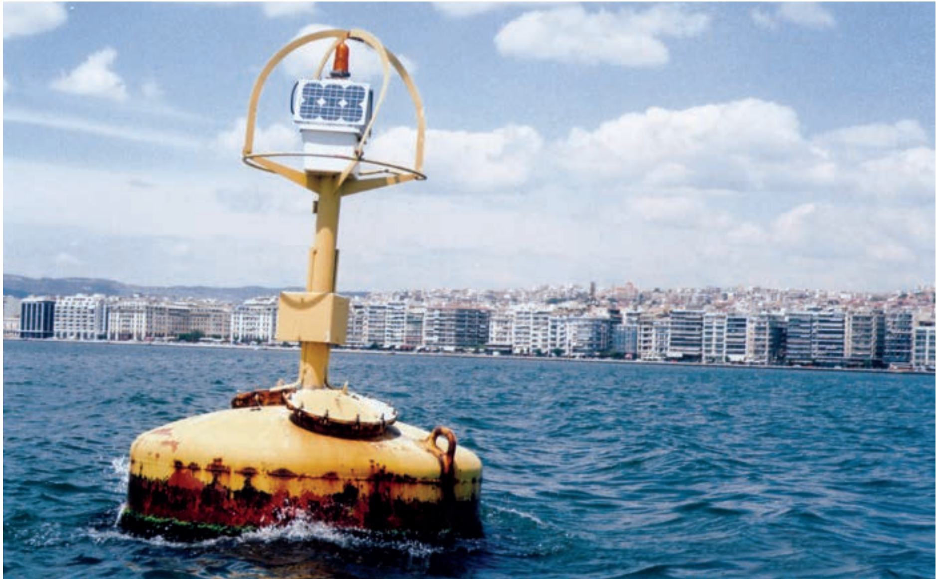
Εικ. 39: Ο φάρος (σπίθα) που δείχνει την έξοδο του αγωγού αποχέτευσης στον Θερμαϊκό κόλπο, 800 μ. από τον Λευκό Πύργο. Λειτουργεί ακόμα με σύγχρονο σύστημα φωτοβολταϊκού συσσωρευτή.
