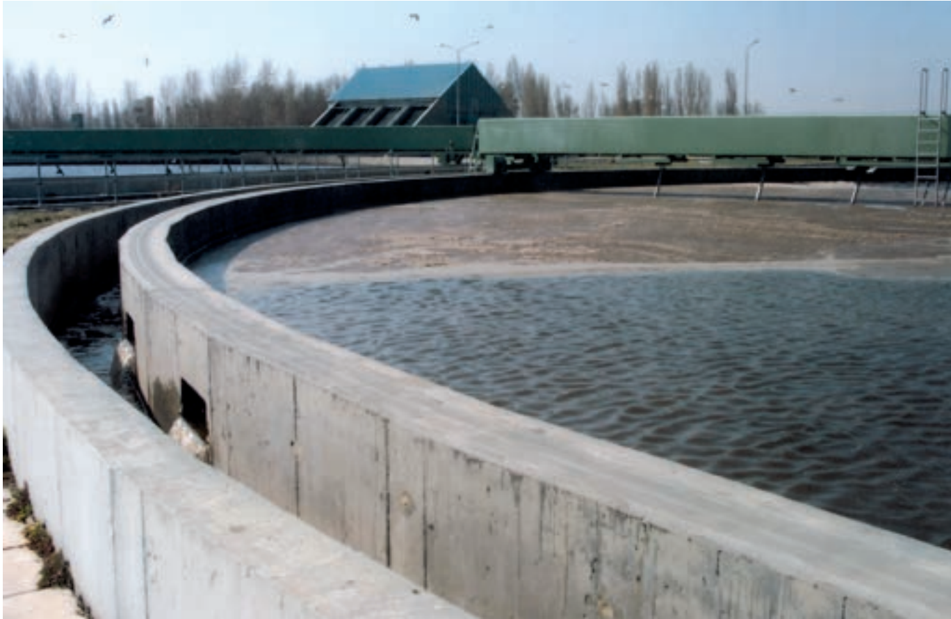
Εικ. 122: Δεξαμενές πρωτοβάθμιας καθίζησης με κανάλι συλλογής του υπερχειλίζοντος υγρού.
