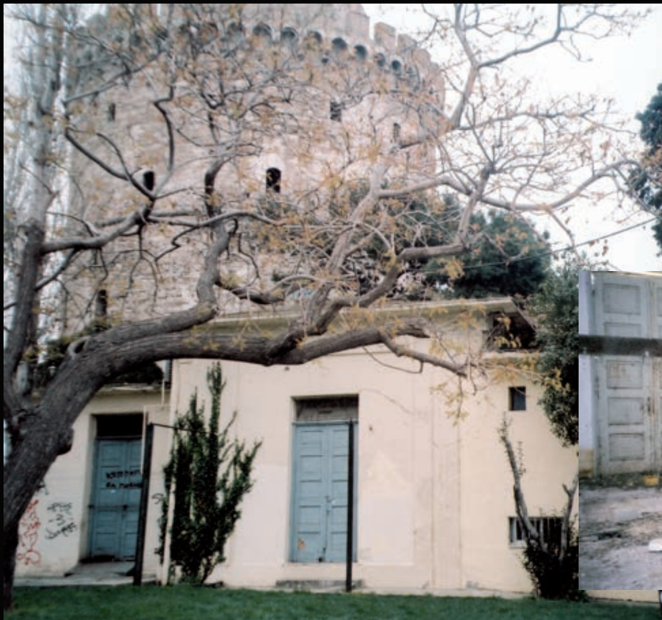
Εικ. 24: Το αντλιοστάσιο του Λευκού Πύργου όπως είναι σήμερα (2004).
