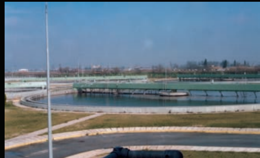
Εικ. 105: Δεξαμενές δευτεροβάθμιας καθίζησης (φωτογραφία: Κ. Κωτούλας).
