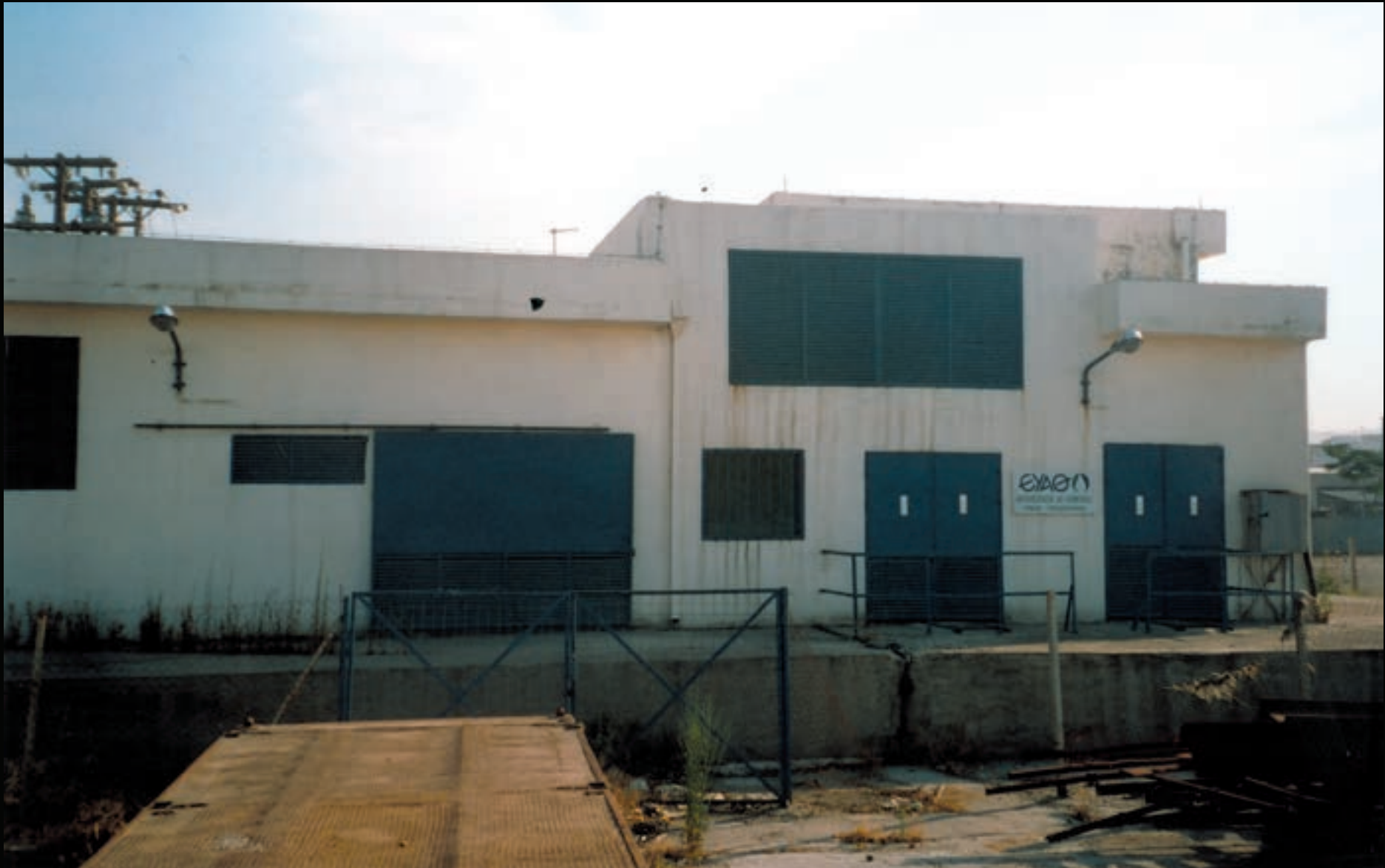
Εικ. 79: Το αντλιοστάσιο Τελωνείου μέσα στο λιμάνι, όπως είναι σήμερα.
