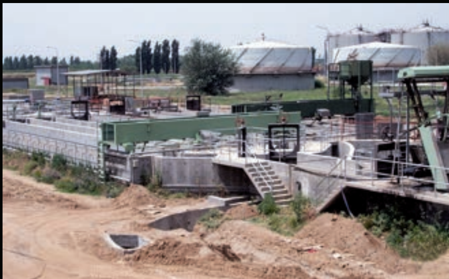
Εικ. 104: Αμμοσυλλέκτης και λιποσυλλέκτης (φωτογραφία: Κ. Κωτούλας).
