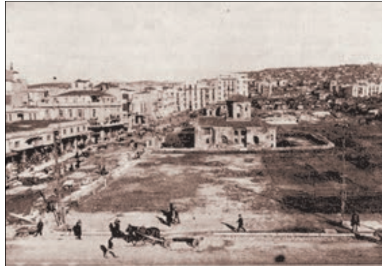
Εικ. 42: Η ισοπέδωση της πλατείας γύρω από τον βυζαντινό ναό της Παναγίας των Χαλκείων (πηγή: Απολογισμός Ετήσιας Δημοτικής Δράσεως 1931-1932).
