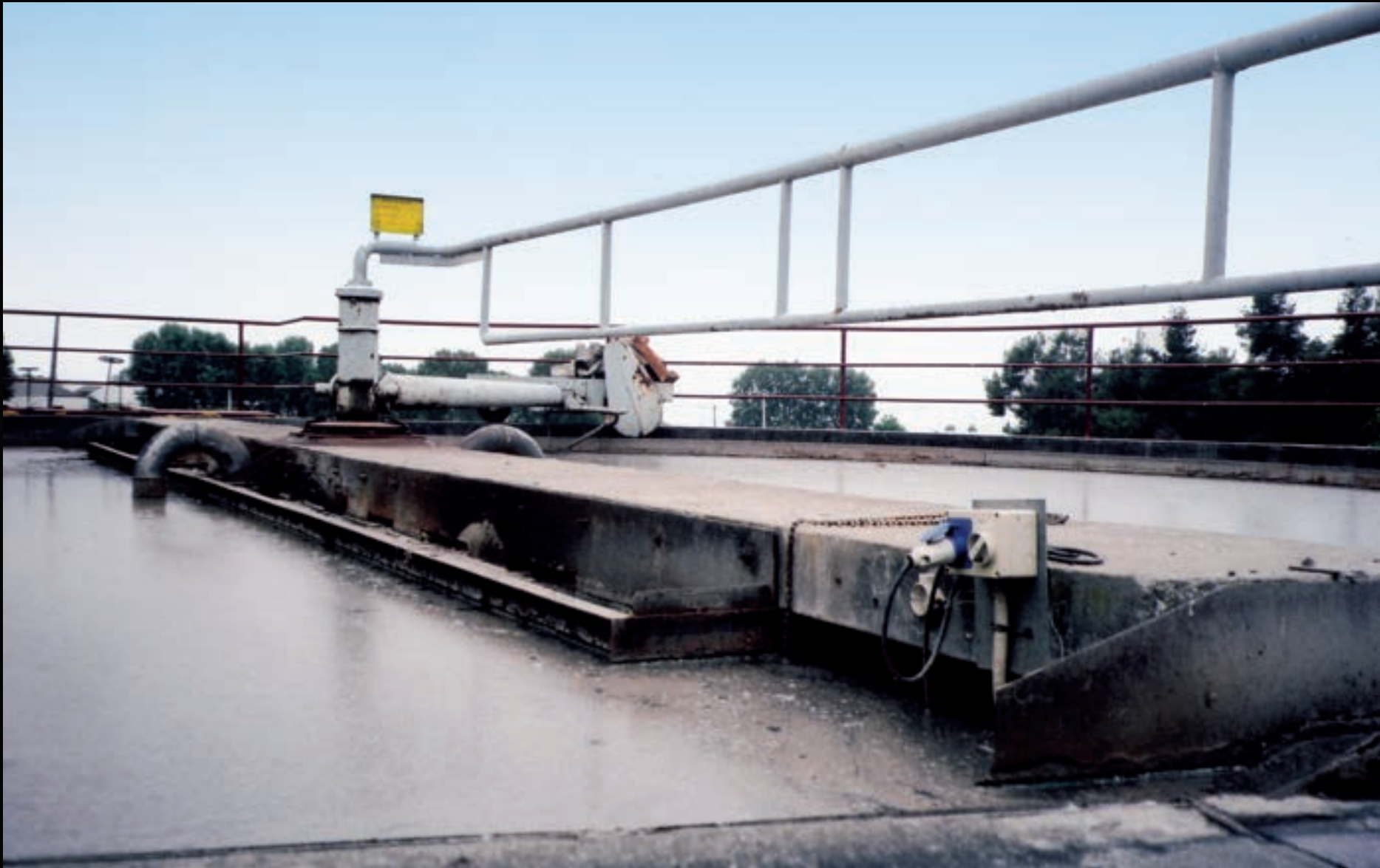
Εικ. 68: Η δεύτερη δεξαμενή καθίζησης του Βιολογικού Καθαρισμού Φοίνικα.
