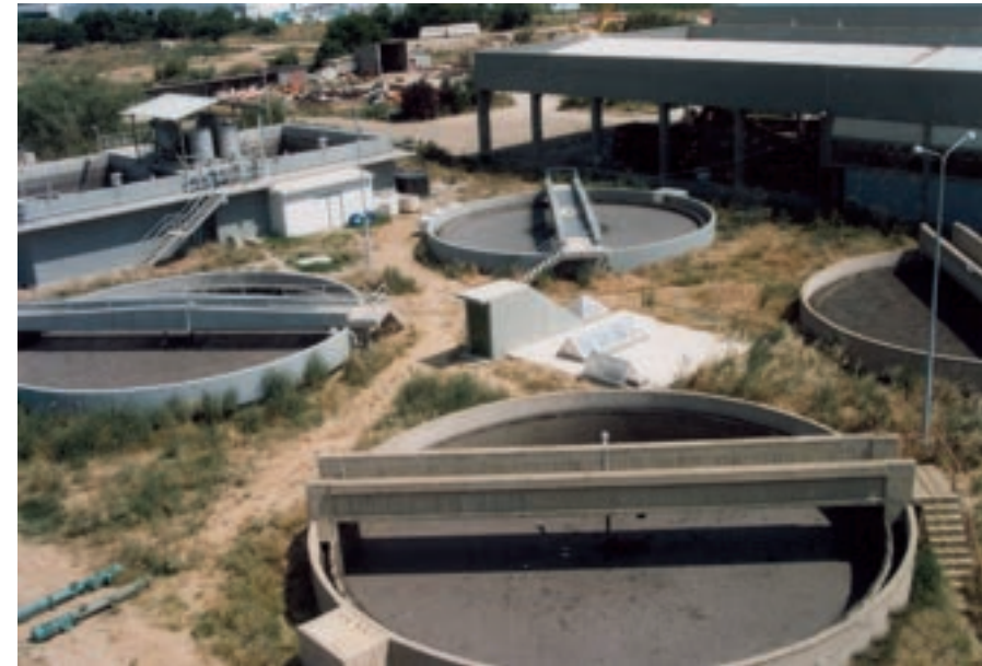
Εικ. 107: Δεξαμενές μεταπάχυνσης λάσπης.
