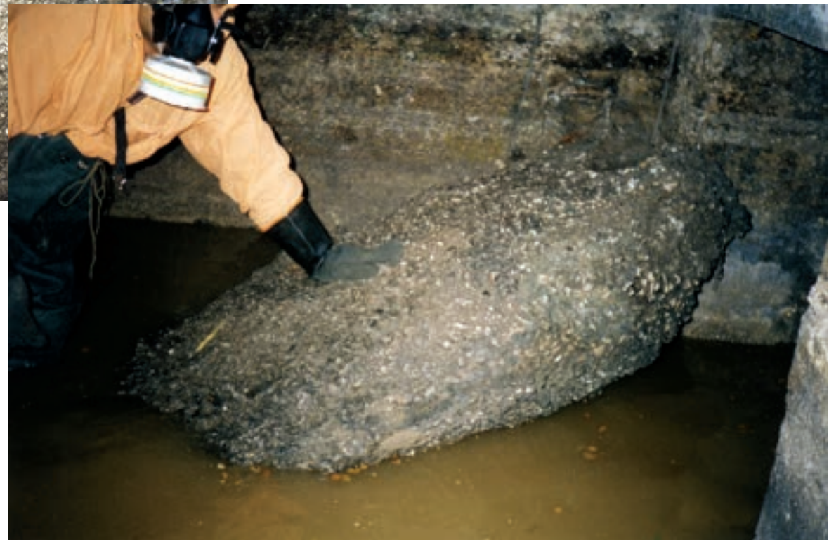
Εικ. 78: Το εσωτερικό κεντρικού αγωγού με τεμάχιο παπλώματος (φωτογραφία: Χρ. Τραγανός).
