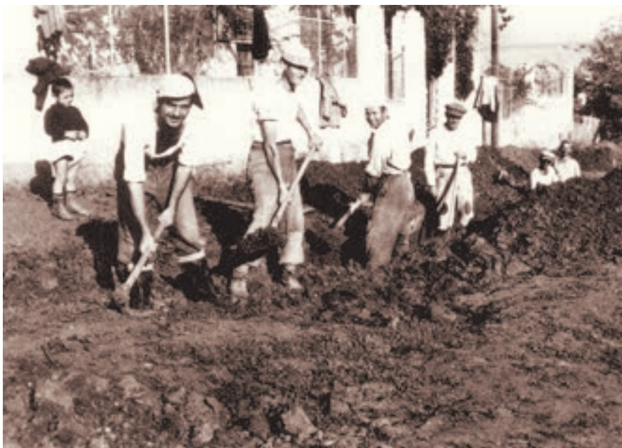
Εικ. 62: Συνεργείο του Δήμου Καλαμαριάς, με αρχιτεχνίτη υπονόμων τον Γιάννη Κατερινόπουλο, εργάζεται για την τοποθέτηση αγωγού στην Καλαμαριά τη δεκαετία του 1950 (φωτογραφία από την ιδιωτική συλλογή του Γ. Κατερινόπουλου).
