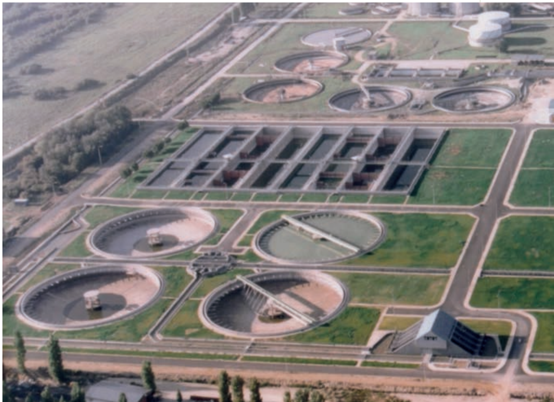
Εικ. 100: Πανοραμική άποψη της Εγκατάστασης Επεξεργασίας Λυμάτων Θεσσαλονίκης στον Γαλλικό ποταμό (φωτογραφία: Κ. Κωτούλας).
