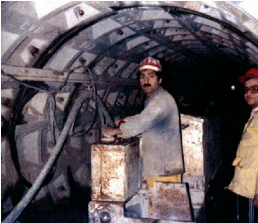
Εικ. 89: Από την κατασκευή του Κ.Α.Α. (φωτογραφία: Ι. Λασκαρίδης).
